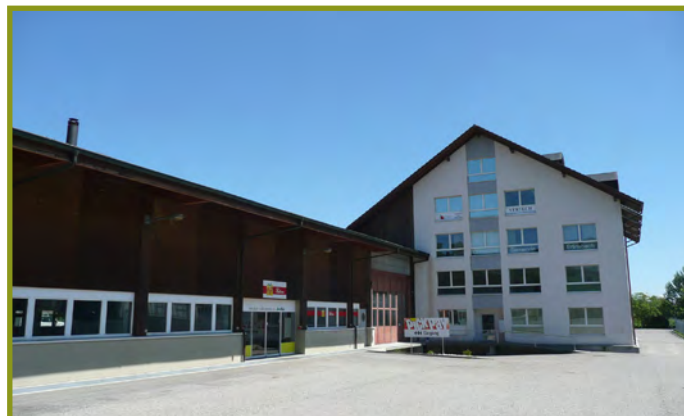
In Erlinsbach steht ein grosszügiges Gewerbezentrum zur Verfügung.
